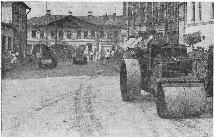
Вместо старых булыжных мостовых московские улицы покрываются усовершенствованными одеждами. На снимке — укатка асфальтовой мостовой на Немецком рынке
