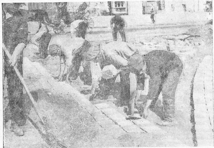
Брусчатка : занимает почетное место на московских площадях. На снимке — укладка брусчатки на Кудринской площади
